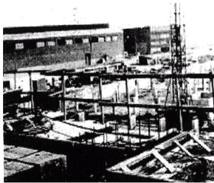
Forjado protegido con barandilla
