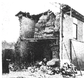
Demolición de edificación
