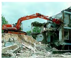
Demolición de muros a máquina ( http://www.cybervillagemall.com )
